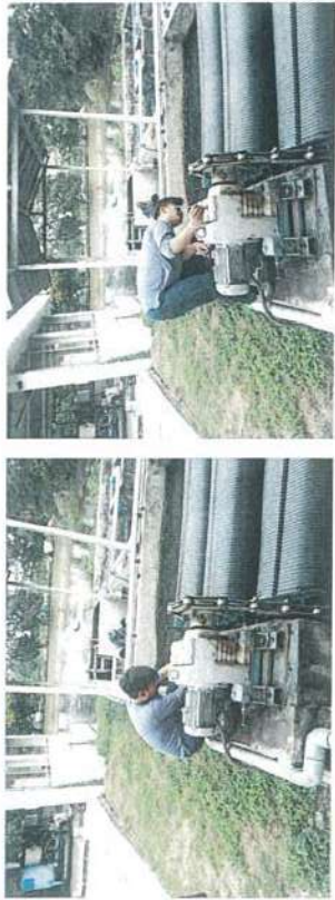
4. เติมน้ำมันกับตัวมอเตอร์
