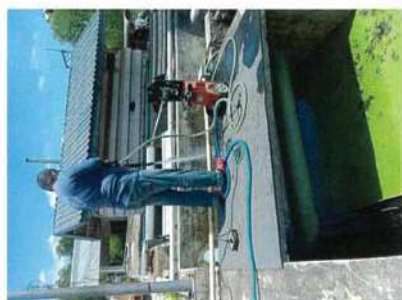
3. งานทำความสะอาดถังเติมอากาศ
